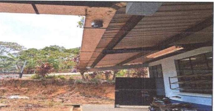
Foto 5: Instalación de pescantes nuevos de canales galvanizados de 35 metros lineales.
